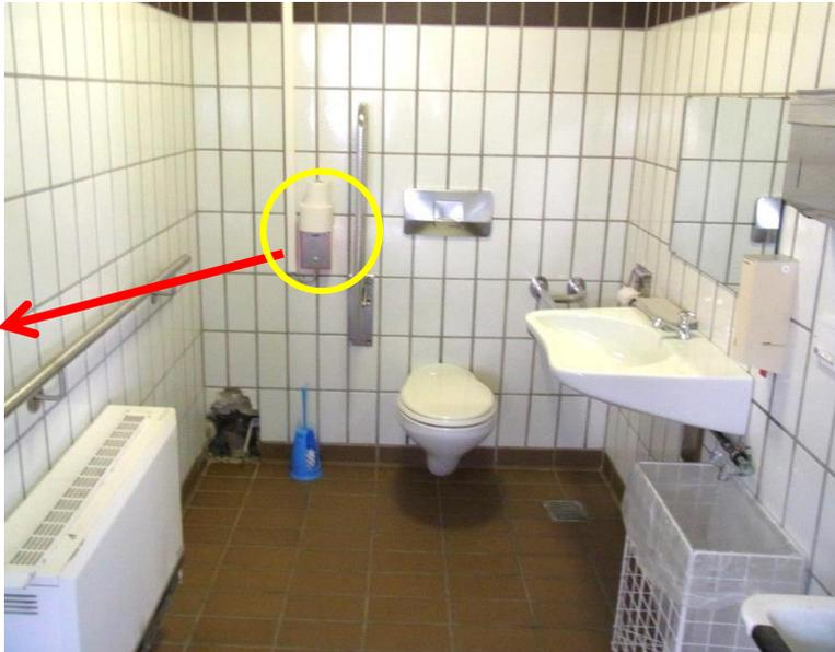
◀ Es gibt im Zugangsgebäude der Tiefgarage eine barrierefreie Toilette, die die baulichen Voraussetzungen der DIN 1804 weitgehend erfüllt. Lediglich der Notruf kann nicht mehr ausgelöst werden, wenn gestürzte Personen hilflos am Boden liegen.
