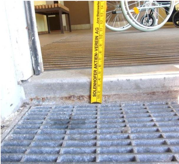
Da jedoch Autofahrer sowie deren Mitfahrer schon mit Rollatoren oder Gehstöcken die Tiefgarage betreten können sollen, stellt die Stufe des Eingangs zur Tiefgarage mit 4 cm Höhe doch eine Barriere dar.
