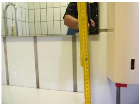
◀ Der Spiegel endet zu hoch über dem Waschbecken und kann von Rollifahrern nicht einfach eingesehen werden. Lösungsvorschlag: Den Spiegel tiefer setzen oder einen nach unten längeren Spiegel anbringen.
