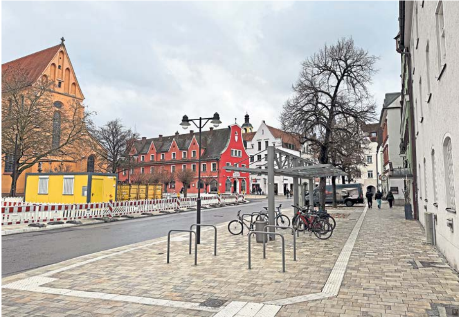
Auf der Westseite ist die Umgestaltung bereits abgeschlossen. Ab März geht es gegenüber mit den Bauarbeiten weiter.
