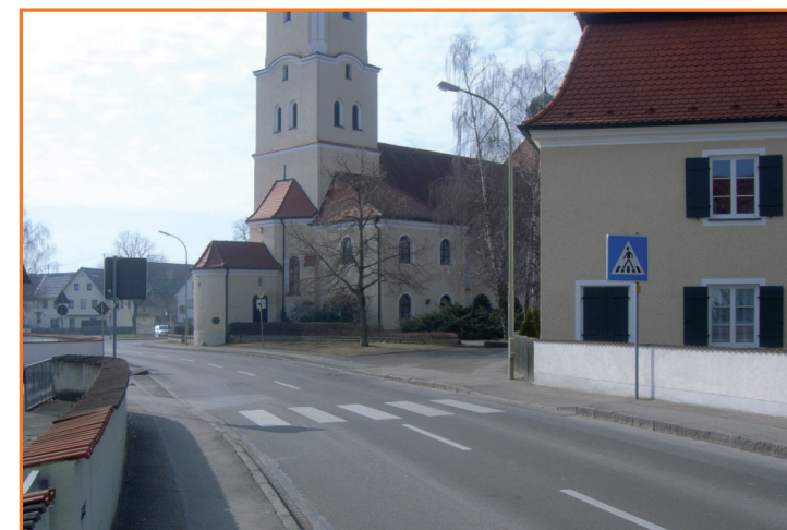
Fußgängerüberweg in der Karlskroner Straße
