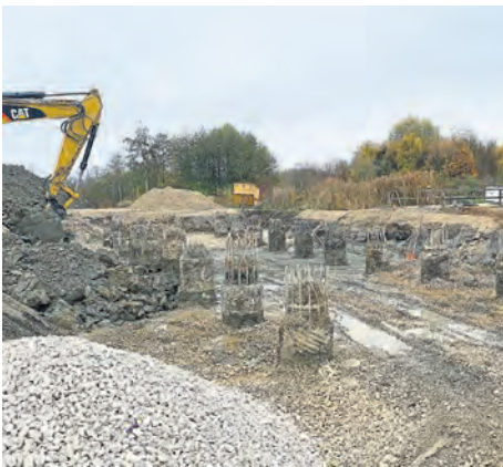
Brücke Schneller Weg
