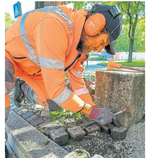
Pflastersteine setzen gehört zu den täglichen Arbeiten der Straßenunterhalts-Mitarbeiter.
