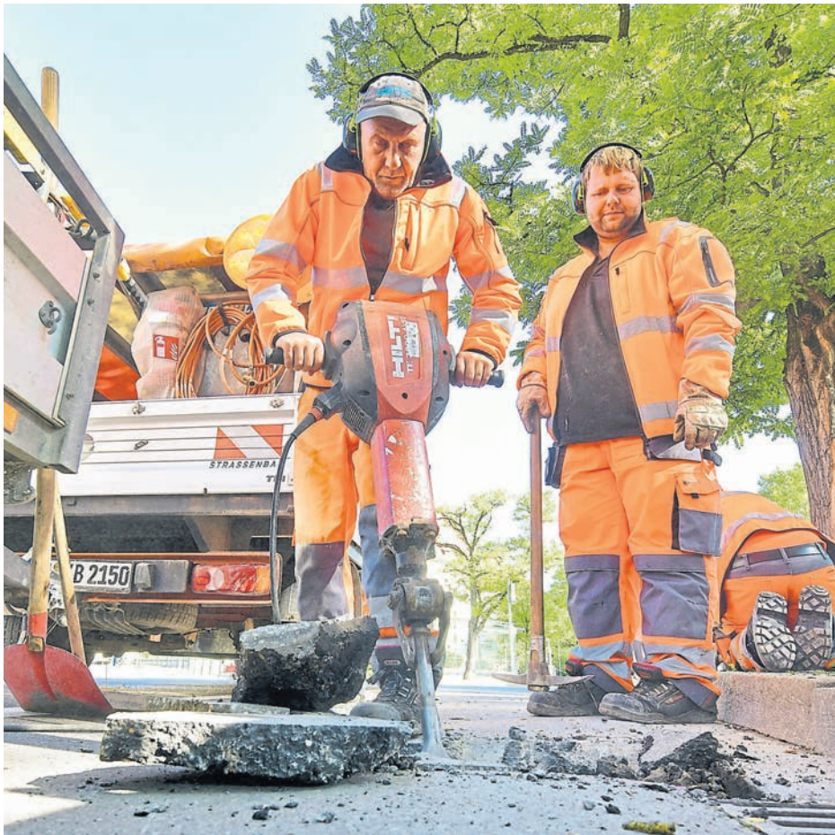
Schwerarbeit für die Männer vom Straßenunterhalt: Rund 40 Kilogramm wiegt der Abrisshammer.
