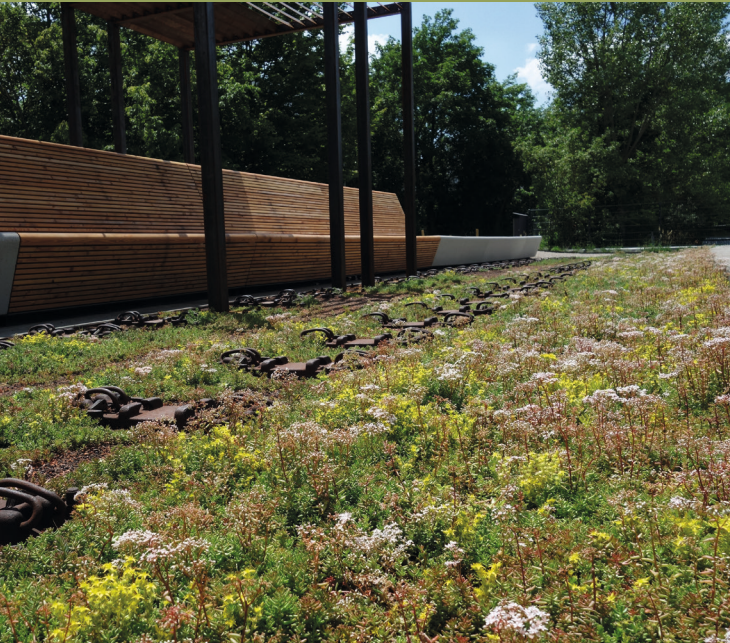
Anschauungsobjekt in Ingolstadt: Highline-Park - Brücke über die Römerstraße, Zugang Schollstraße
