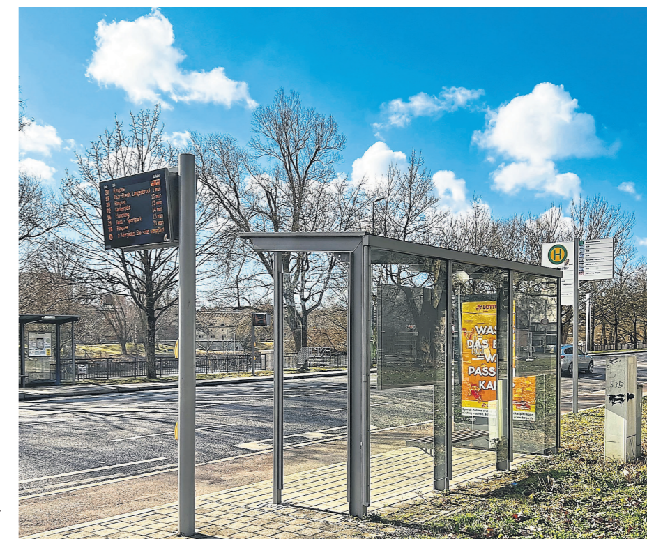
Die Bushaltestelle Stadttheater / Schlosslände soll als erstes mit einem begrüntem Dach ausgestattet werden.
