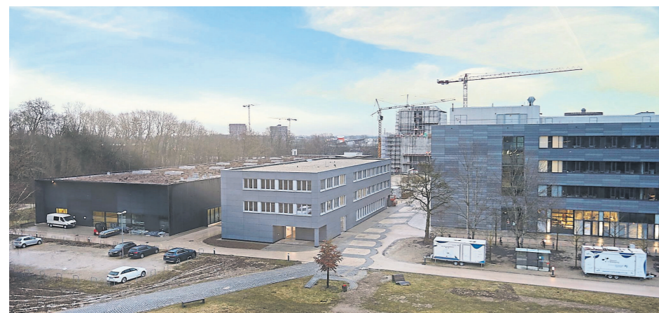
Der neue Modulbau auf dem Campus der THI wurde in nur neun Monaten errichtet. Foto: THI
