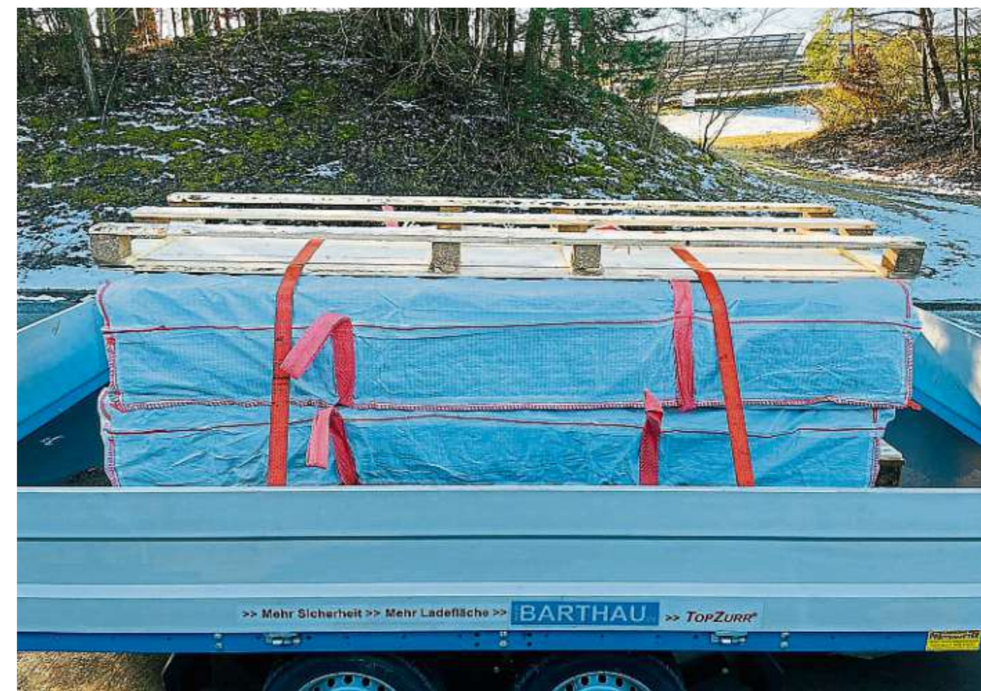
Asbest richtig angeliefert auf der Deponie – geschlossen und verpackt in BigBags mit den Schlaufen nach oben.
