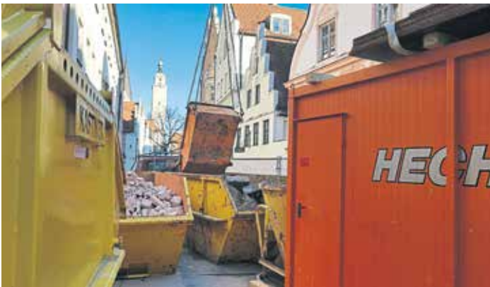
Enge auf der Baustelle
