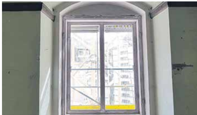
Überarbeitung der Fensterrahmen
