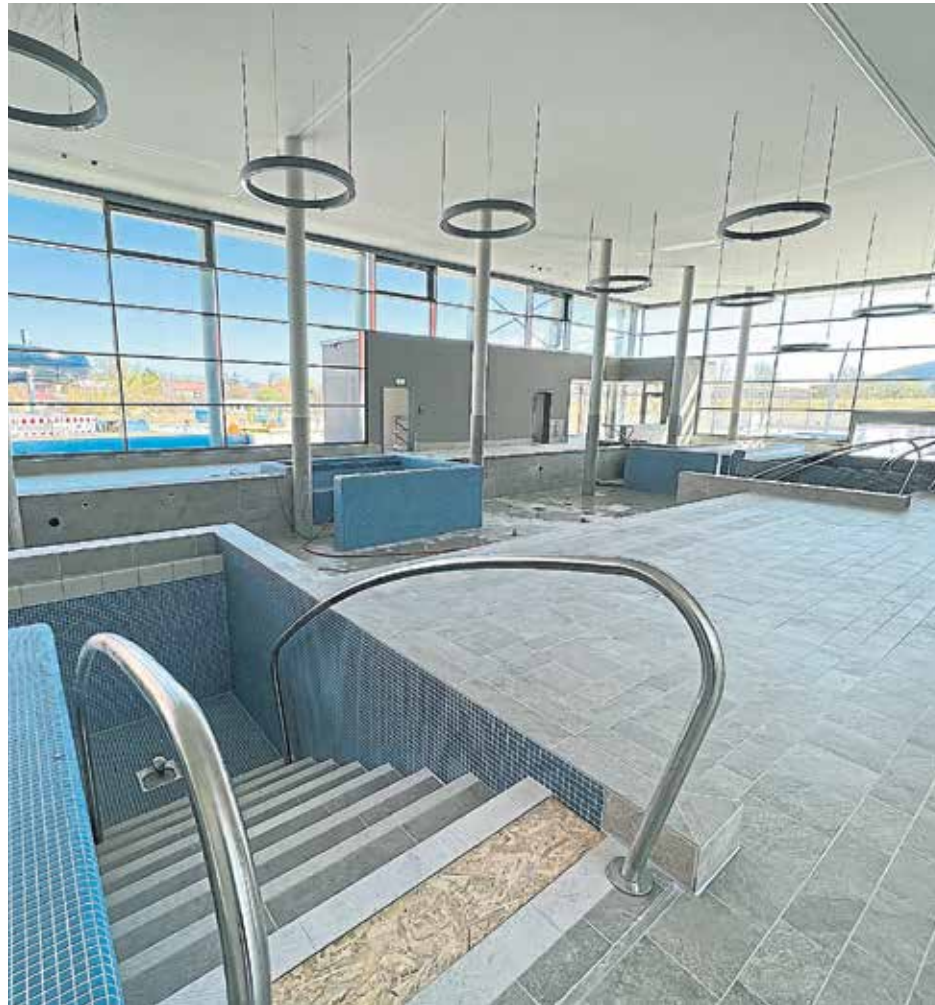
Blick in den komplett neuen Thermenbereich.
