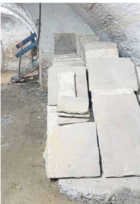
Nummerierte Steinplatten warten auf den Wiedereinbau
