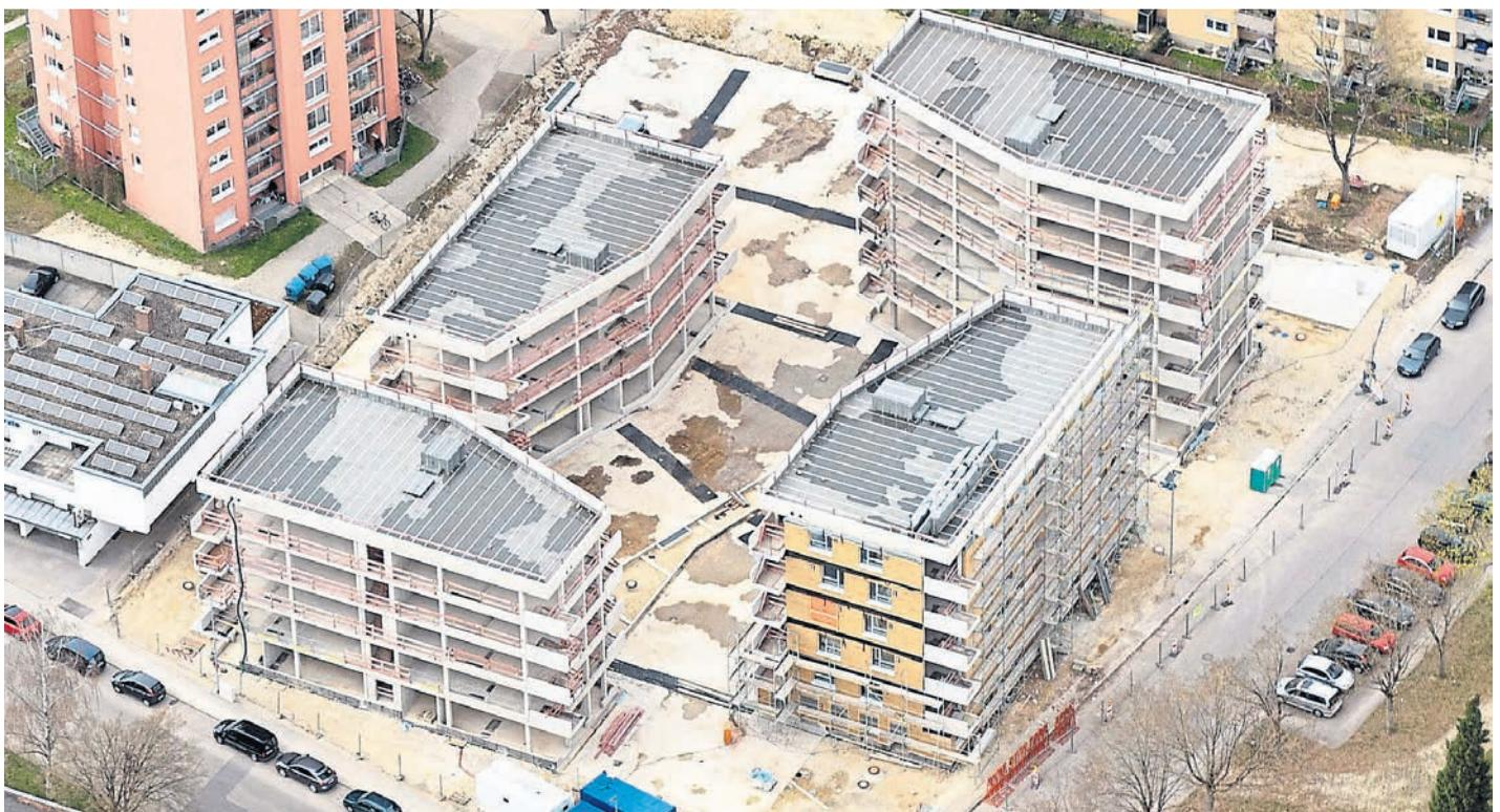
Ein Foto aus der Rohbauphase zeigt, dass lediglich die tragenden Elemente wie eine Art Skelett aus Beton gefertigt sind.
