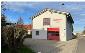
Feuerwehrhaus Pettenhofen Moosweg 9
