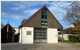
Feuerwehrhaus Dünzlau Mühlackerweg 2
