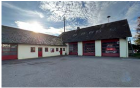
Feuerwehrhaus Gerolfing Barthlgasserstraße 7
