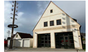
Feuerwehrhaus Zuchering Am Kühlhaus 4
