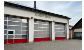
Feuerwehrhaus Usnerhenn Karl-Theodor-Straße 7
