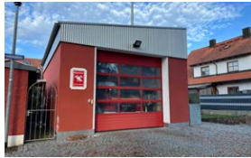
Feuerwehrhaus Friedrichshofen Friedrichshofener Straße 26c
