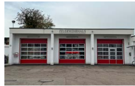
Feuerwehrhaus Haunwöhr Oberfeldstraße 6
