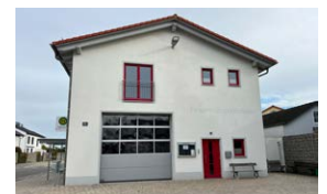
Feuerwehrhaus Rothenturm Usnerherrner Straße 31a
