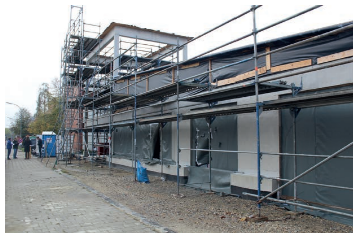
Neubau des Stadtteiltreffs von außen
