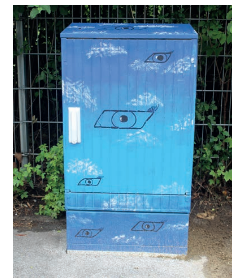
Wenigstraße, kurz vor der Südlichen Ringstraße
