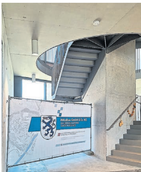
Das Foyer des Neubaus.
