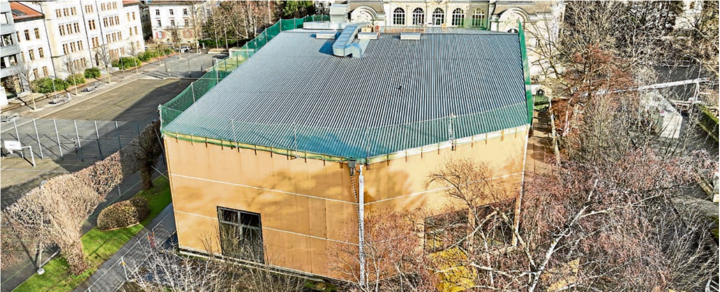
In Sankt Gallen erfolgte der Abbau des Gebäudes, anschließend der Transport nach Ingolstadt und dort Wiederaufbau.
