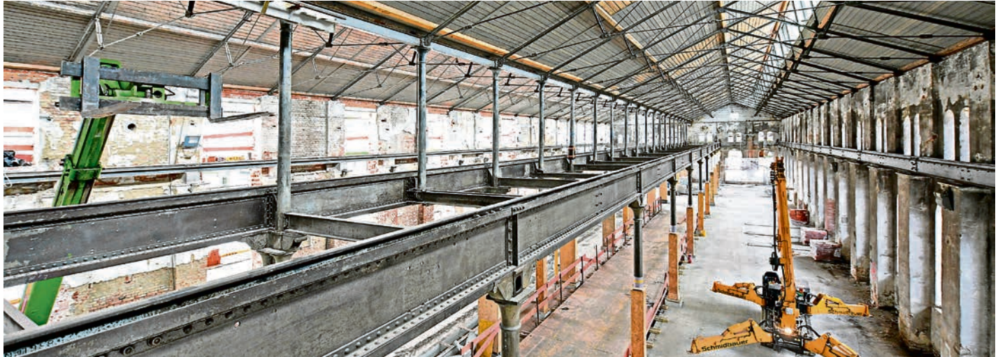
Die restaurierten Gussstützen tragen nun wieder die historische Kranbahn.
