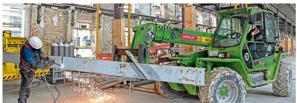
Als nächstes beginnt im Frühjahr der Einbau der Fenster.
