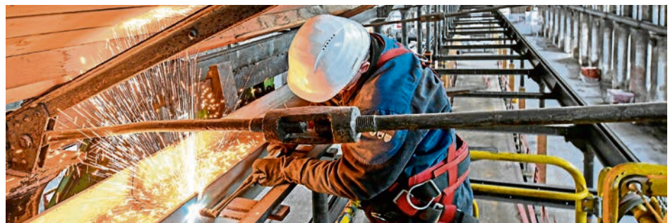
Das Hilfstragwerk am Dach konnte jetzt wieder ausgebaut werden.
