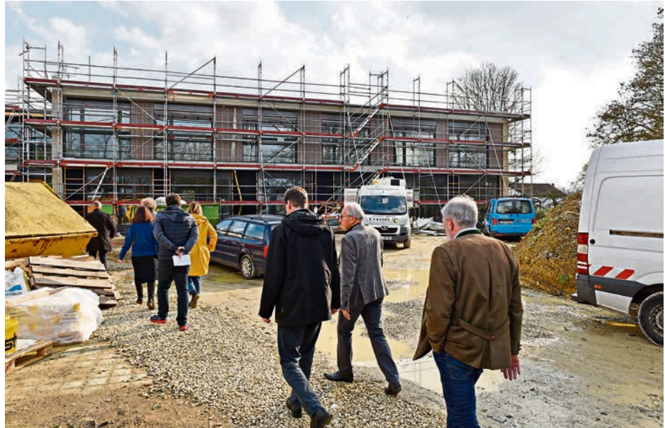
Die Mitglieder des Stadtrates machten sich bei einem Ortstermin ein Bild vom Fortschritt am Erweiterungsbau der Grundschule.
