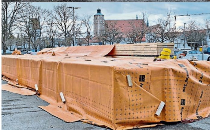
Die Bauteile werden aktuell zwischengelagert.
