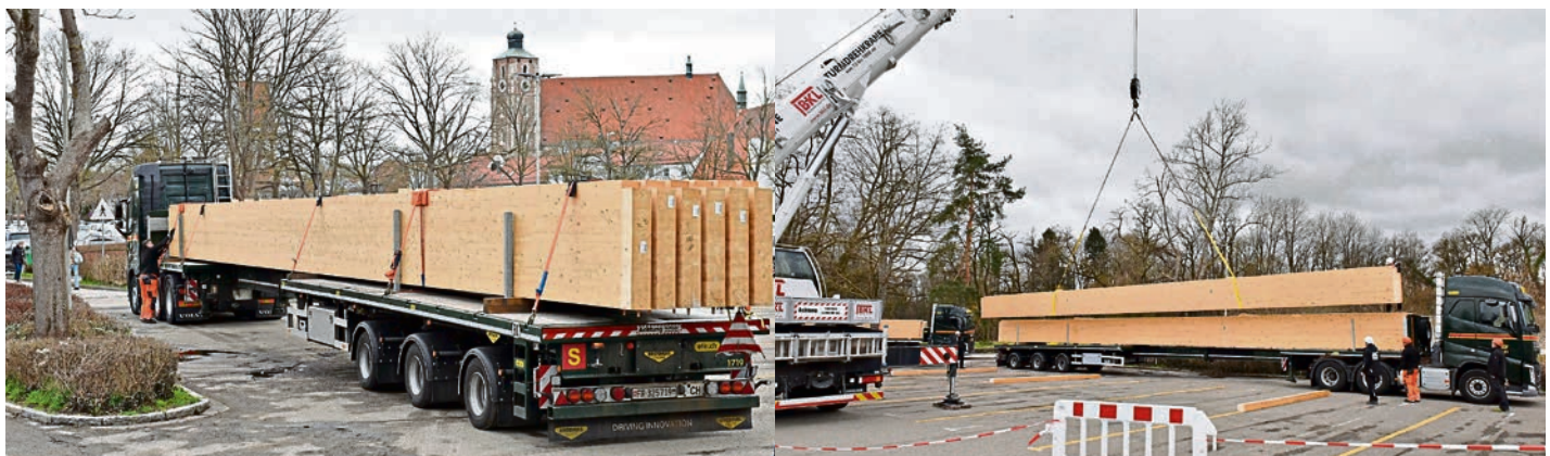
Die in der Schweiz abgebauten Teile wurden mit Schwertransportern nach Ingolstadt gebracht.
