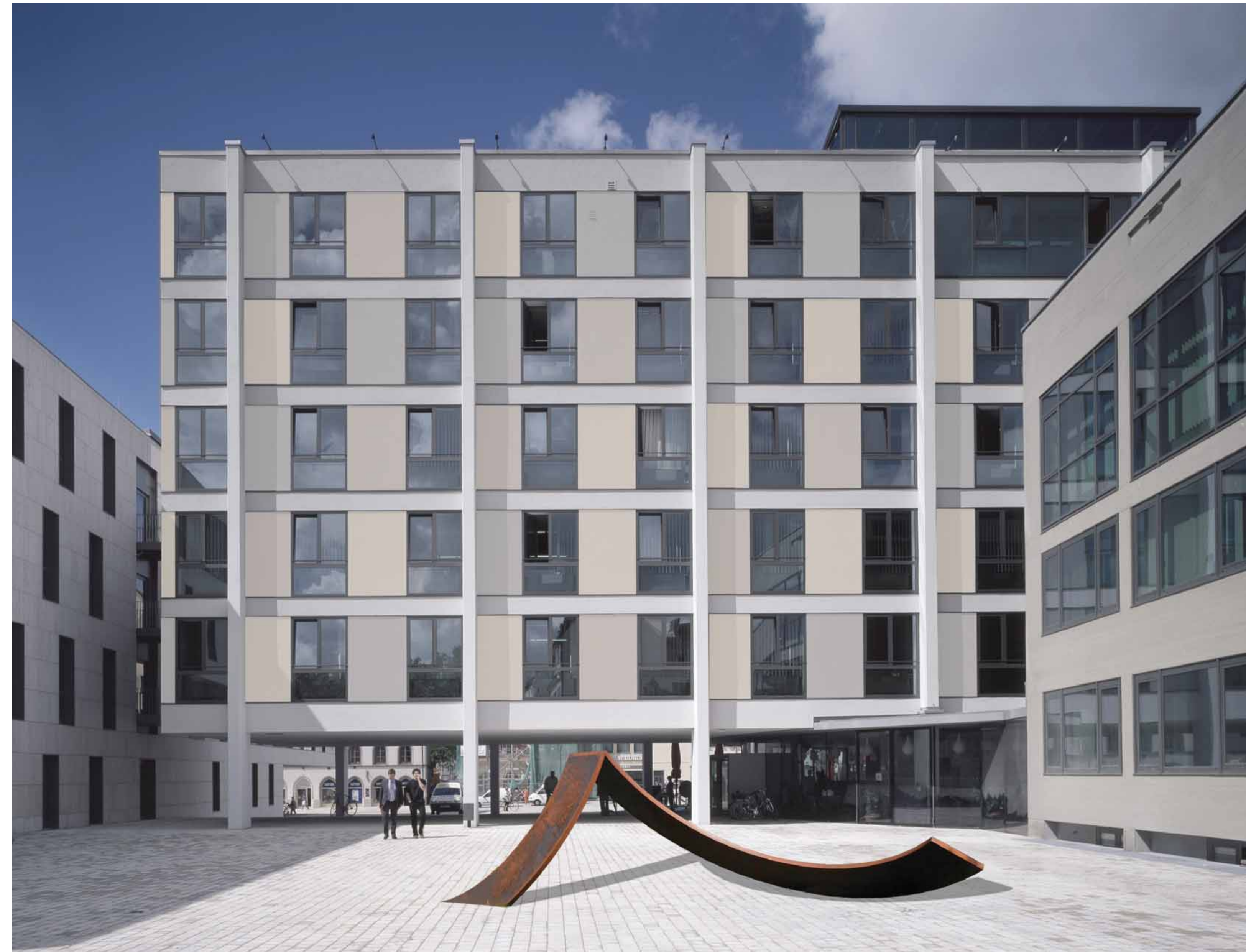
Simulation Skulpturenhof, beispielhaft mit Werk von Alf Lechner + neuer Farbigkeit Fassade Neues Rathaus
