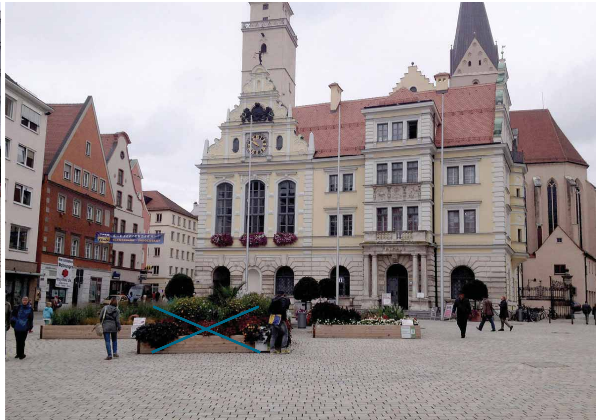
Entfernung Pflanztröge zur Wiederherstellung der Sicht- + Wegebeziehungen
