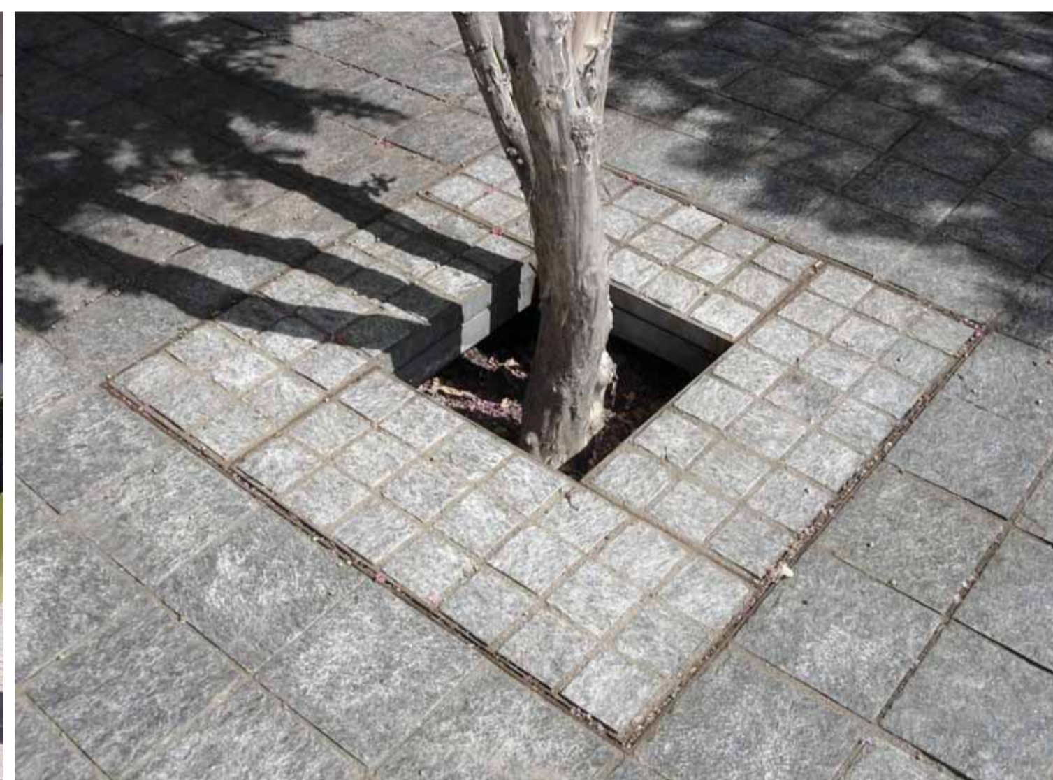
Beispiel für Integration Baumscheibe in Pflasterfläche
