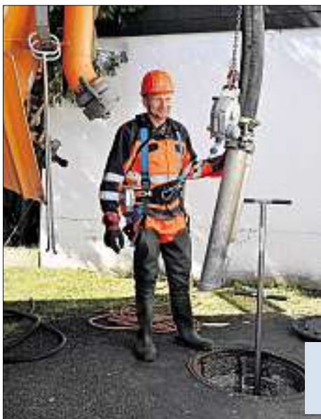
Maximilian Ledig vor und während des Einstiegs in den Pumpensumpf mit kompletter Schutzausrüstung.
