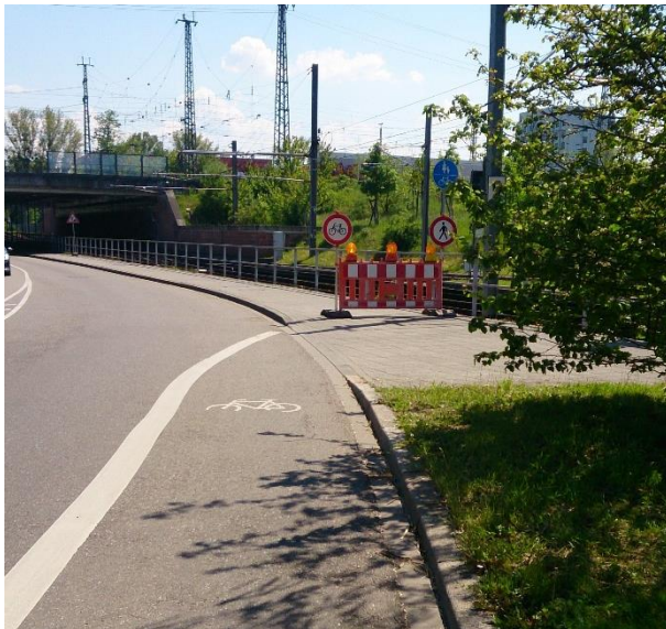
Abbildung 28 Beispiel für eine ungenügende Beachtung des Radverkehrs bei Baumaßnahmen (Bsp. Karlsruhe)
