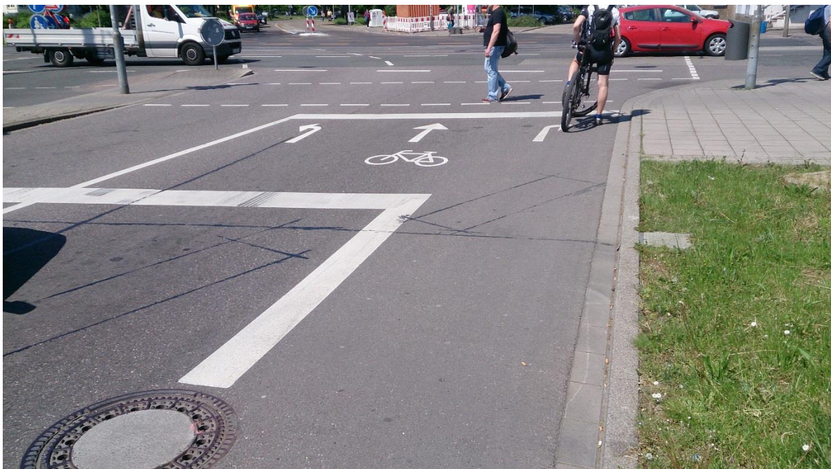
Abbildung 22 Aufgeweiteter Radaufstellstreifen an signalisiertem Knotenpunkt (Bsp. Karlsruhe)
