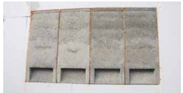
Fledermauskasten in der Wärmedämmung (Rohbau) © Sylvia Weber
