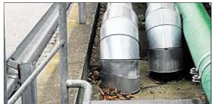
4. Die Müllverwertungsanlage liefert Wärme und Strom an die benachbarte Zentralkläranlage.
