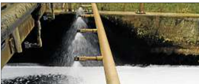
6. Die MVA liefert Rauchgaswaschwasser sowie Regenerierwasser (zur Schaumbekämpfung) zur ZKA.
