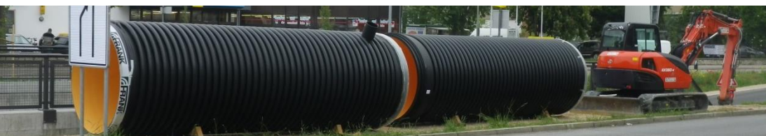
Kanalbaustelle Hindenburgstraße Rohr-Durchmesser 1,80 Meter
