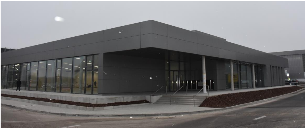
Fertigstellung Betriebsrestaurant im GVZ
