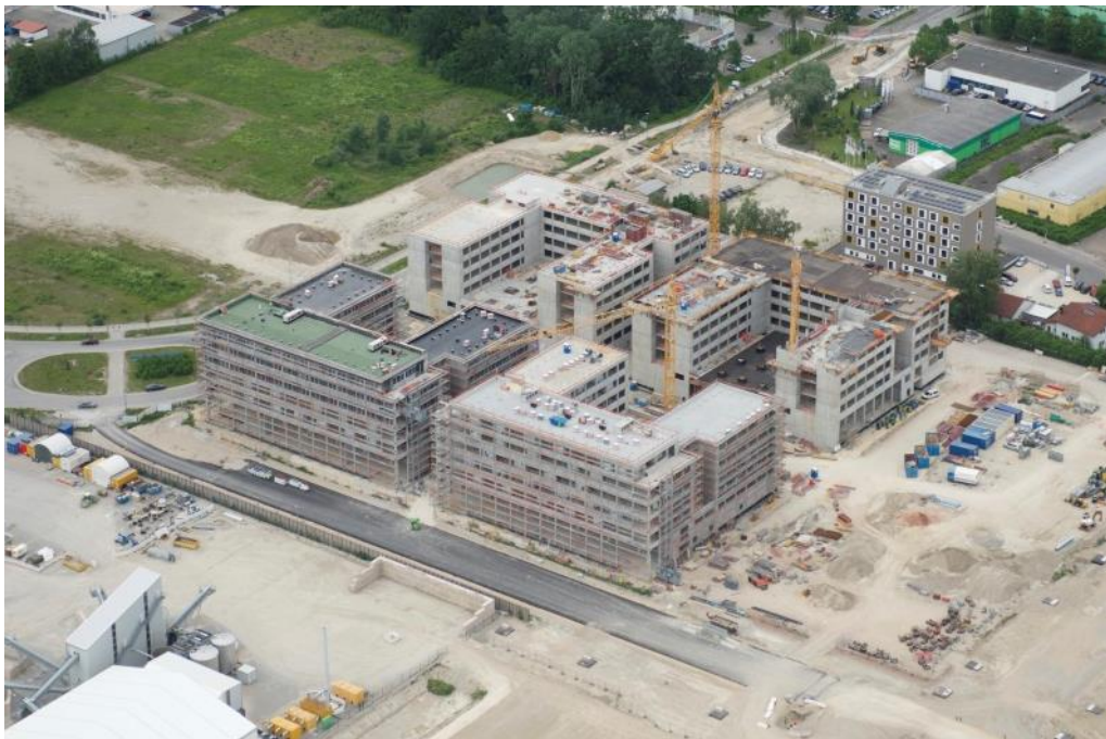
Bau des Bürokomplexes „Projekthaus“ auf dem Gelände der IN-Campus GmbH
