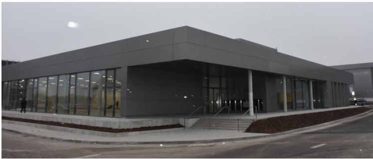
Fertigstellung Betriebsrestaurant im GVG
