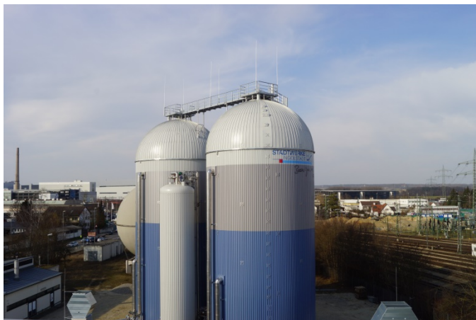
Wärmespeicher an der Ringlerstraße
