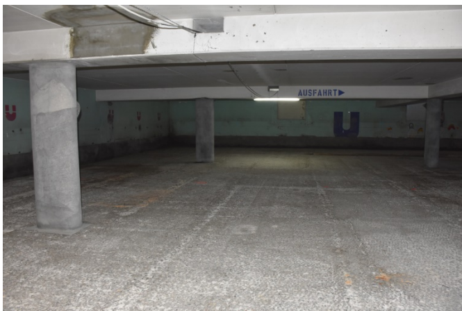
Sanierung Tiefgarage Schloß
