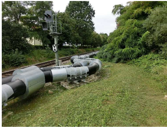
Abb. 7: Westlicher Bereich des Grundstücks mit im Süden angrenzender Bahntrasse und Leitungsvorrichtung.
