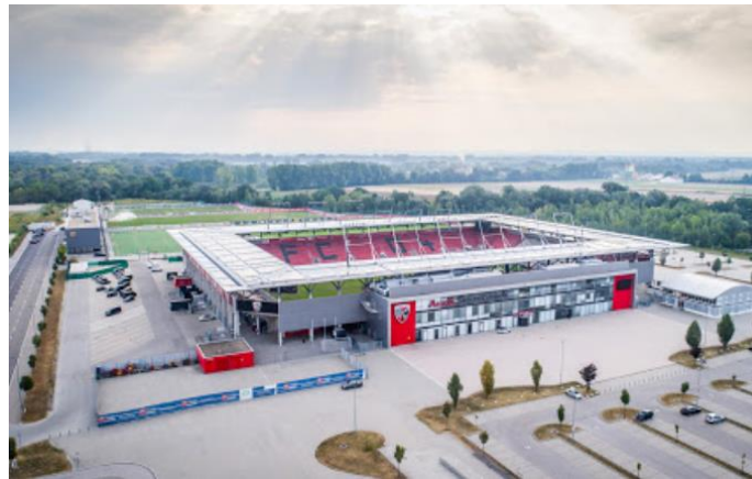
Photovoltaikanlage auf Dach des Audi Sportparks
