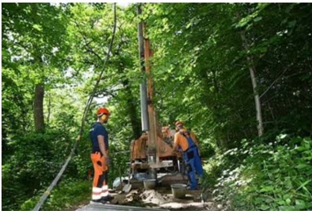
Sondierbohrung im Gerolfinger Eichenwald
