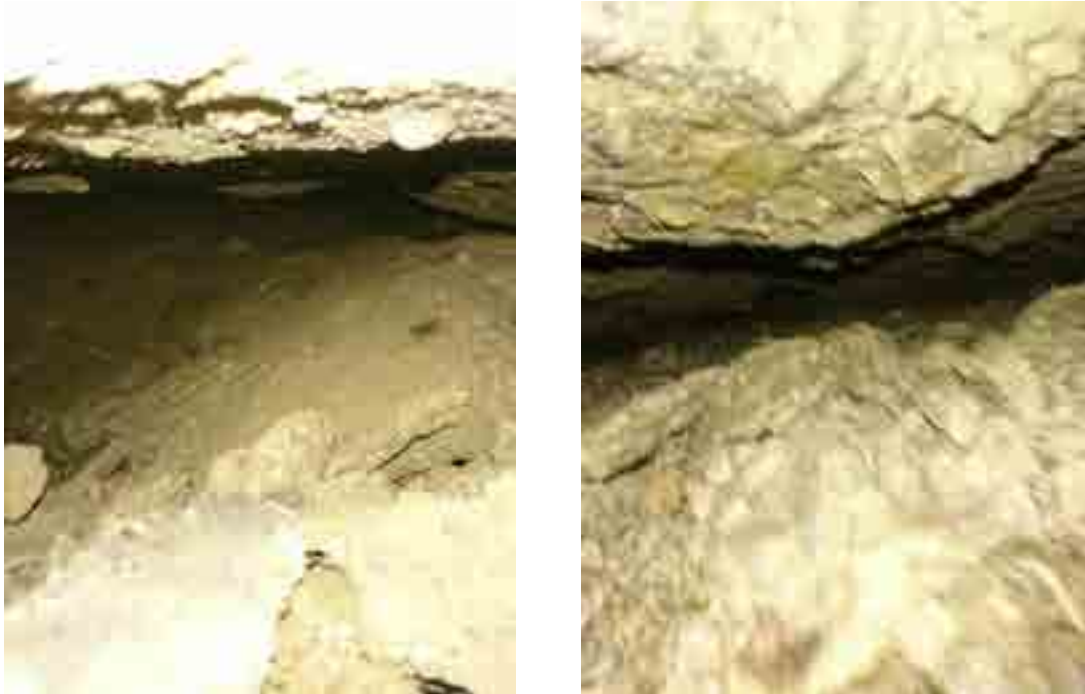
Abb. (1): Aufnahmen des Hohlraumes unter der Bodenplatte
