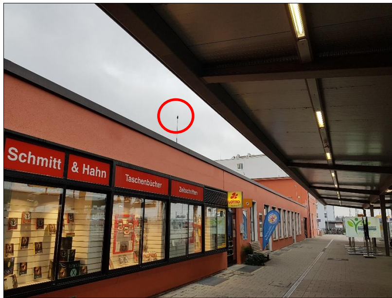
Abbildung 7. Messposition (roter Kreis) auf dem Dach des bestehenden Bahnhofsgebäudes vom Bahnsteig aus gesehen.
