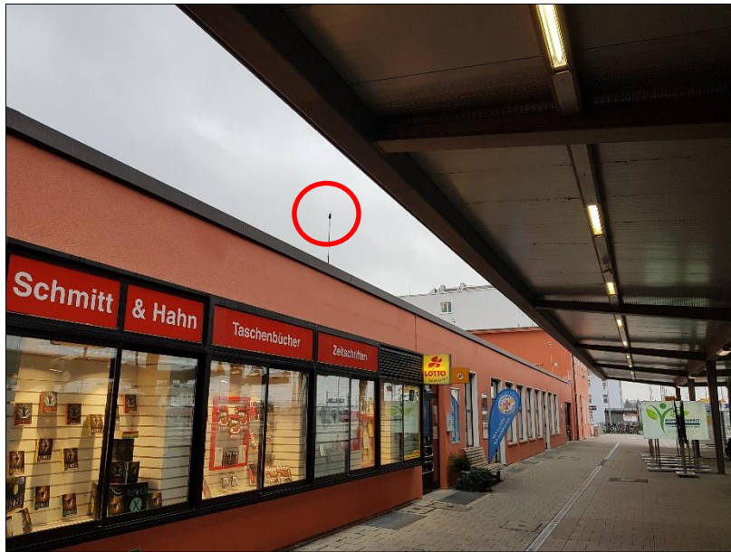
Abbildung 7. Messposition (roter Kreis) auf dem Dach des bestehenden Bahnhofsgebäudes vom Bahnsteig aus gesehen.
