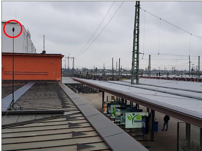
Abbildung 6. Messposition (roter Kreis) des Mikrofons auf dem Dach des bestehenden Bahnhofsgebäudes.
