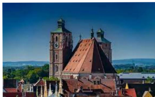
Münster Zur Schönen Unserer Lieben Frau oder Liebfrauenmünster, katholische Pfarrkirche Grundsteinlegung im Jahr 1425
