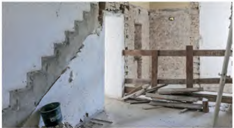
Abb. 83: Weitreichende Umbauarbeiten für ein neues Treppenhaus
