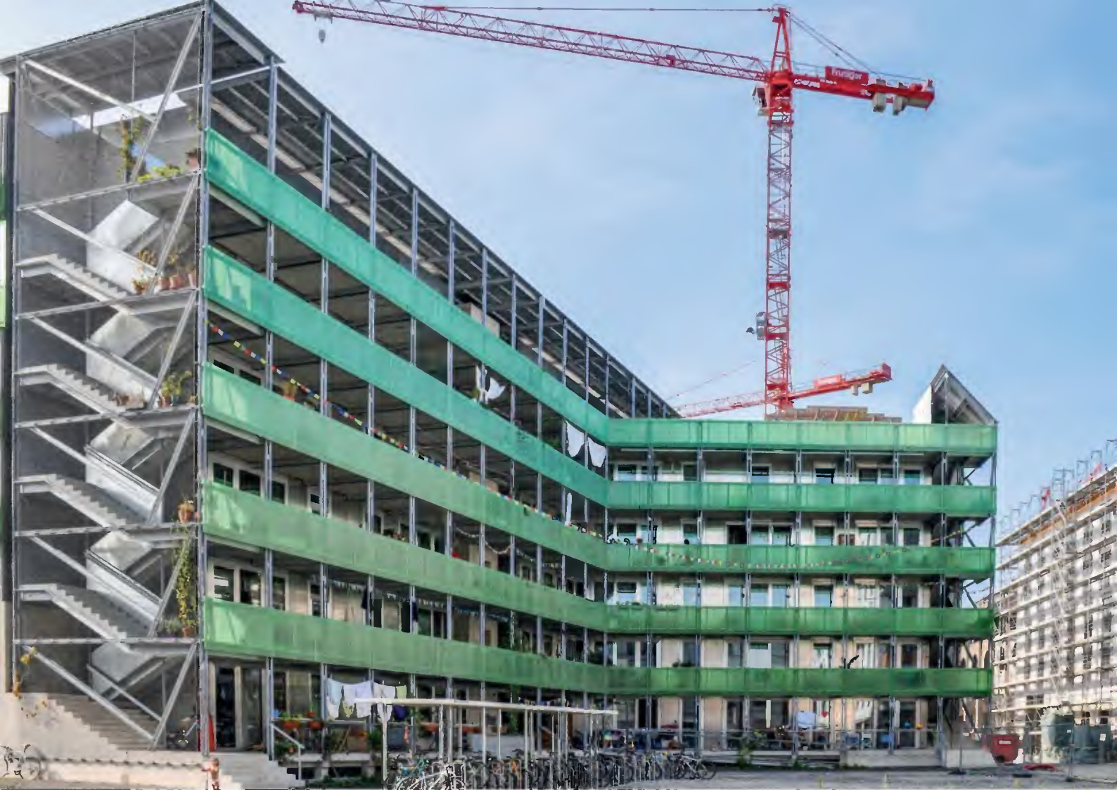
Abb. 70: StadtErle, Hof-Fassade mit sichtbarer Außenerschließung
