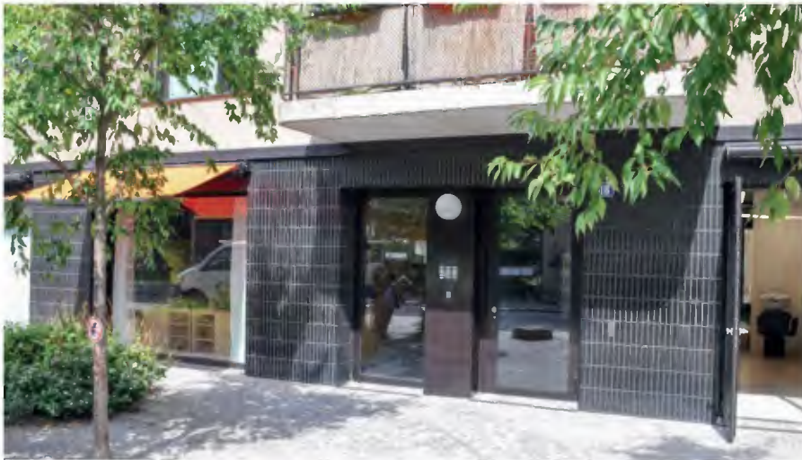
Abb. 35: Hauseingang und Gewerbeeingänge im EG
