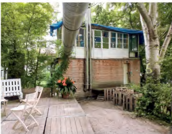
Abb. 12: Heizhaus und Gartenterrasse
