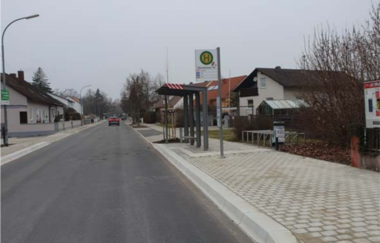
Beispiel Oberstimmer Straße ohne Dach:
