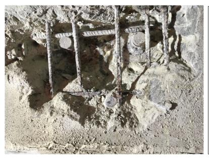
Schaden Endquerträger mit freigelegten Spangliedköpfen: Bewehrungsstahl mit Lochfrasskorrosion aufgrund Chlorideinwirkung
