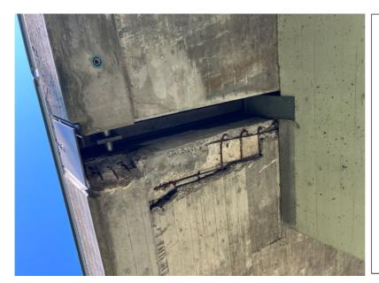
Schaden Kragarm: unmittelbar an der Übergangskonstruktion Kragarm abgerissen, freiliegende Bewehrung
