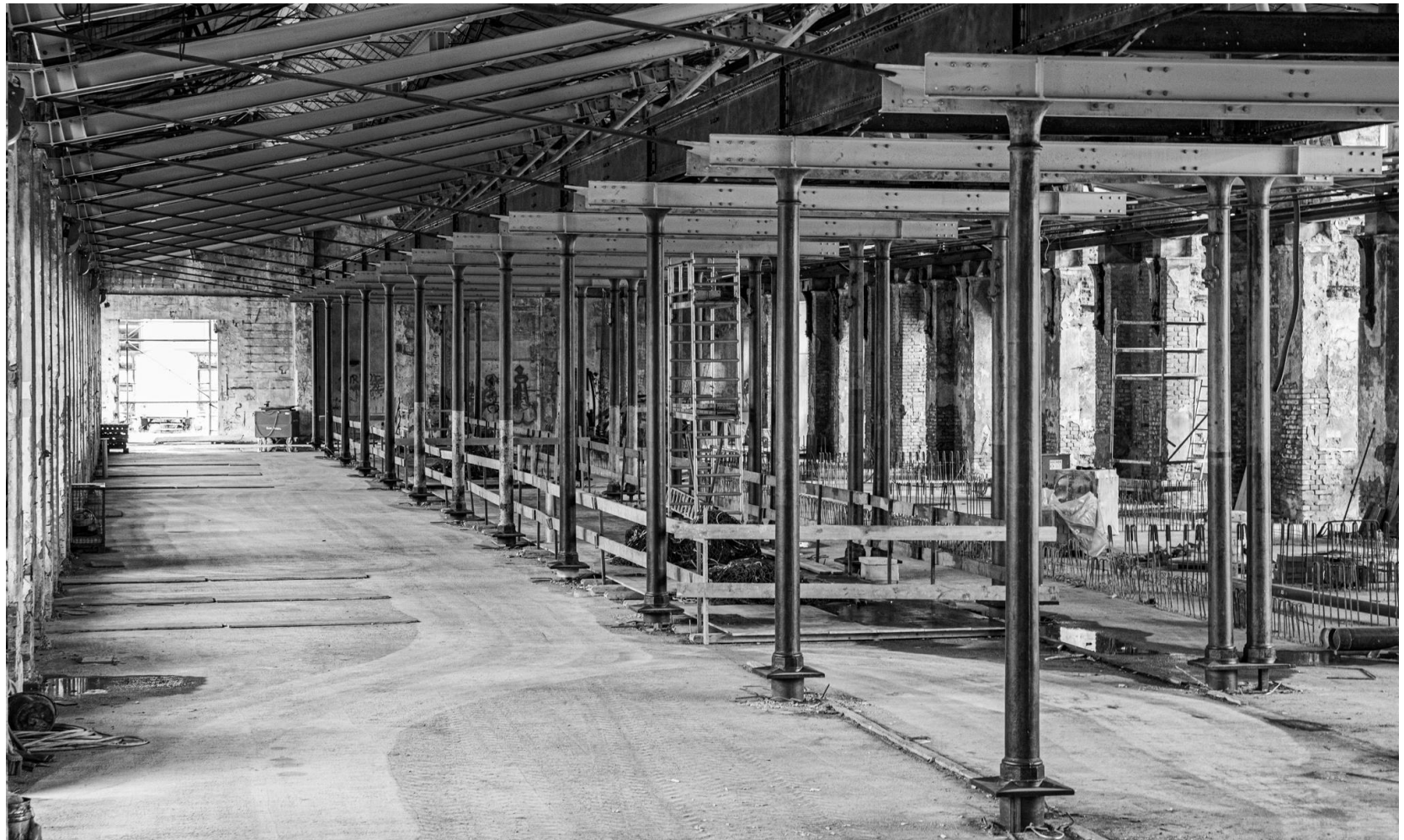
Einbau historischer Gussstützen im EG
