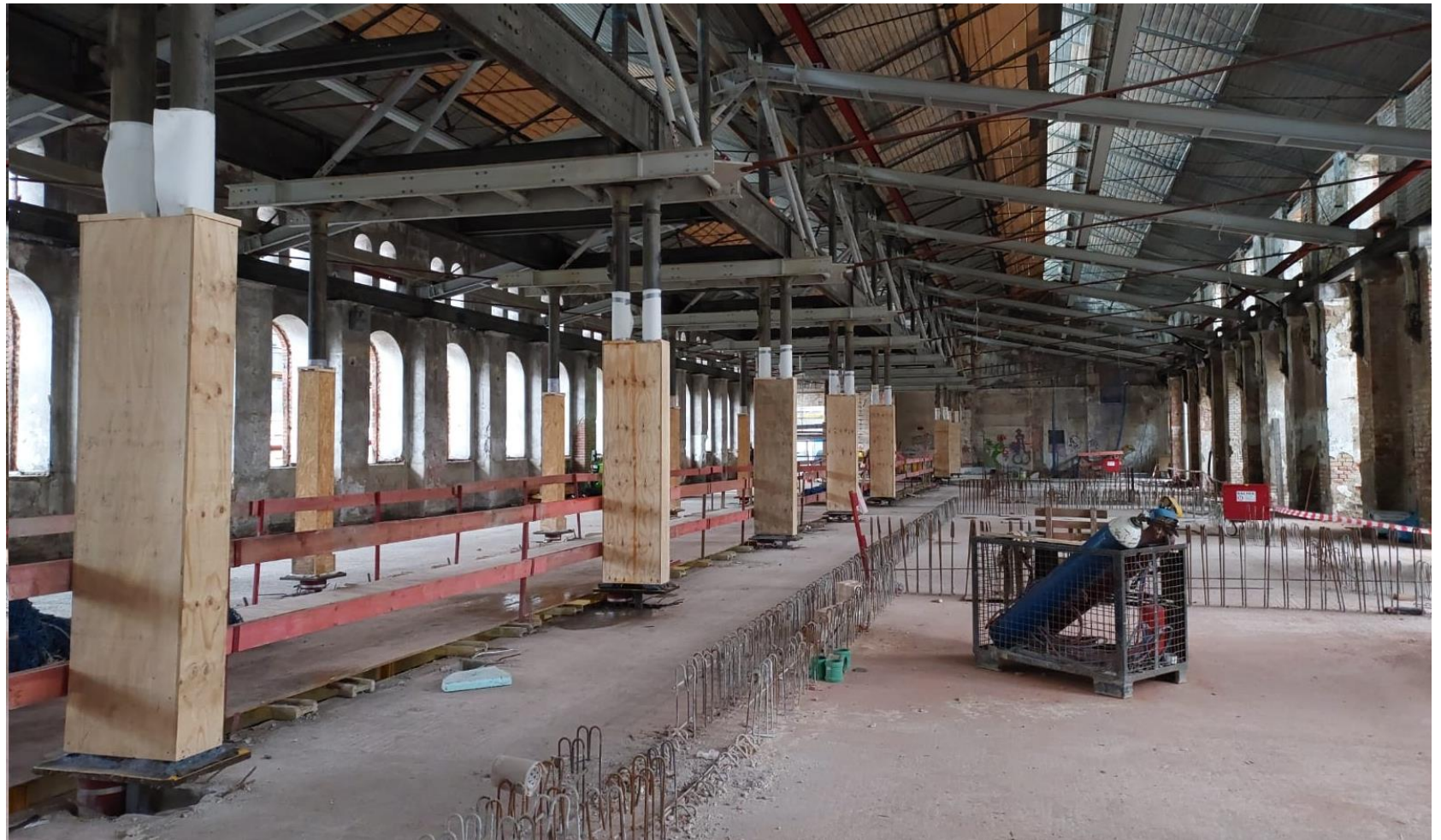
EG, Perspektive von West nach Ost – eingebaute historische Gussstützen
