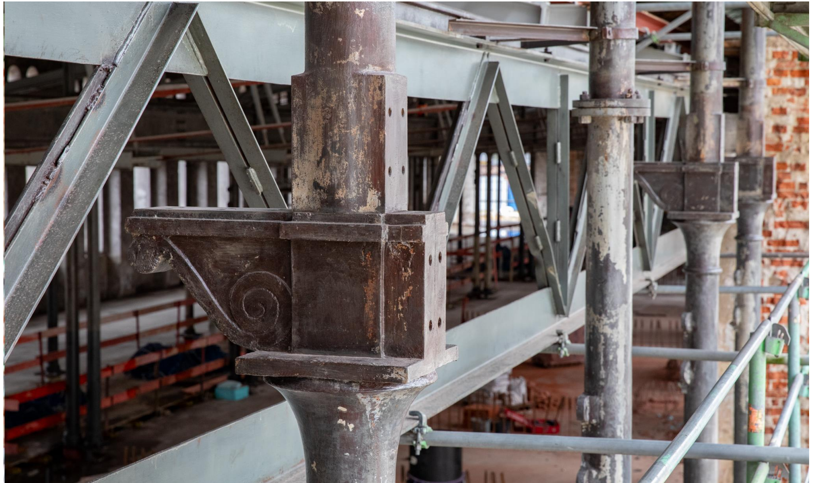
Einbau historischer Gussstützen im EG / Anschluss Gussäulen an Kranbahn
