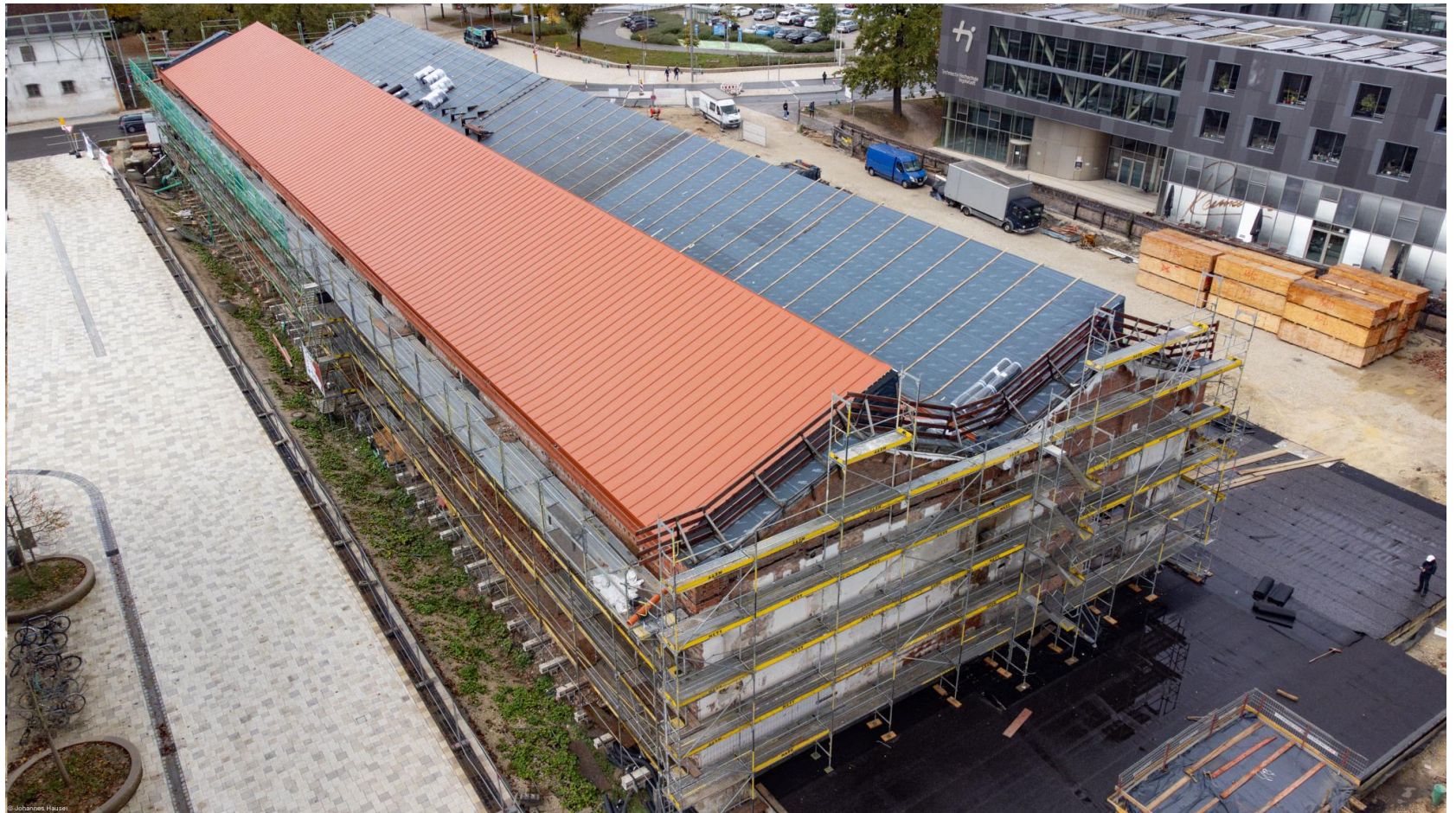
Sanierung des Daches (Blechabdeckung Traufe Südseite)
