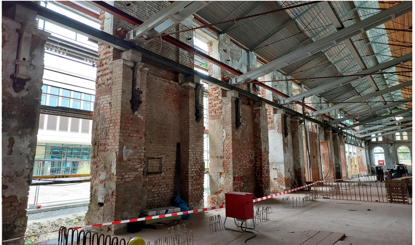
Fassadendurchbrüche Fensterbänder Südseite
