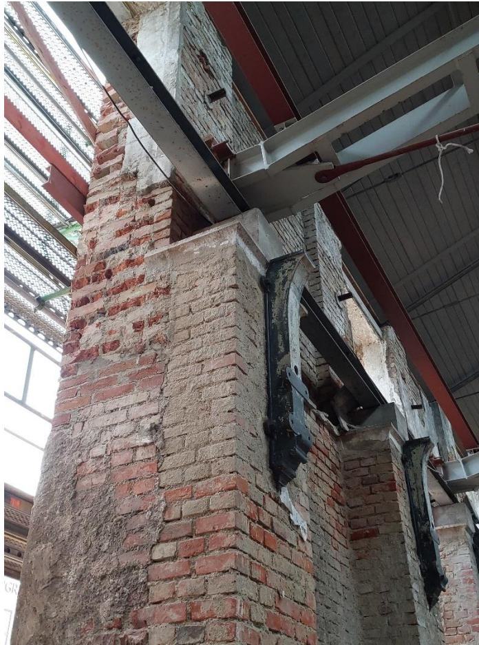
Fassadenanschluss Kranbahnträger
