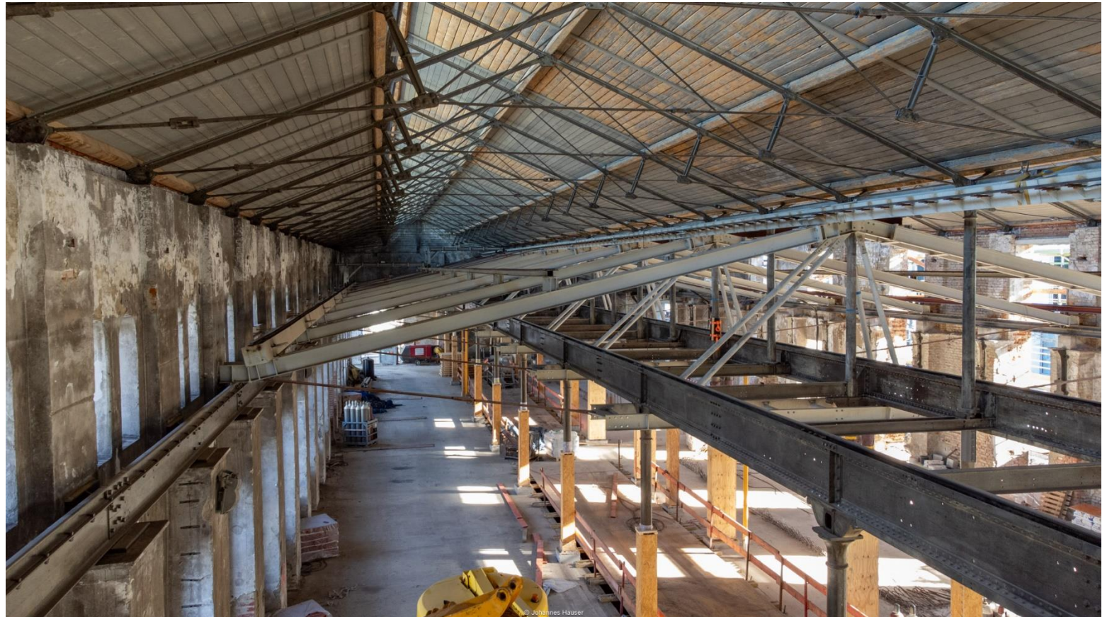
Rückbau der temporären Dachhilfskonstruktion
