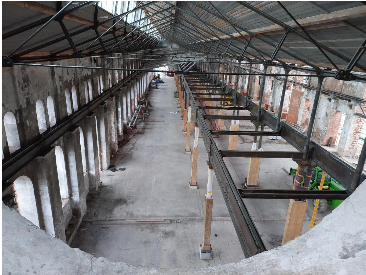
Blick auf die wiedereingebauten historischen Gussstützen im EG
