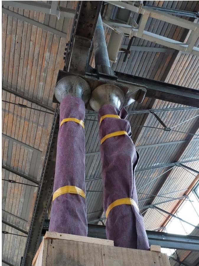
Historische Gussstützen im EG / Anschluss Gussäulen an Kranbahn
