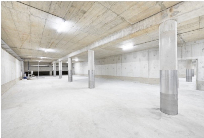
INKB - eine von drei Kammern des Regenklärbeckens Südost - größtes unterirdisches Bauwerk der Unternehmensgeschichte
