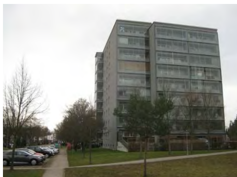
Sanierung Wohngebäude und Wohnumfeldgestaltung Herschelstraße (GWG)
