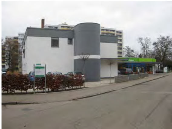
Verbesserung und Zusammenfügung der Vorbereiche: Arztpraxis und Lebensmittelladen Pfitznerstraße
