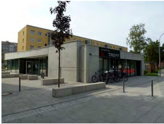
Stadtteiltreff Pfitznerstraße mit Vorplatz
