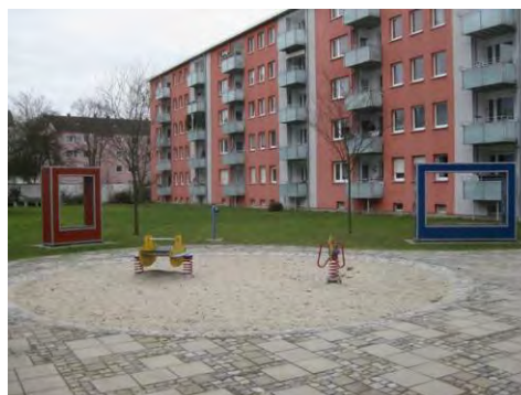
Sanierung Wohngebäude und Wohnumfeldgestaltung Rossinistraße (Südhausbau KG)
