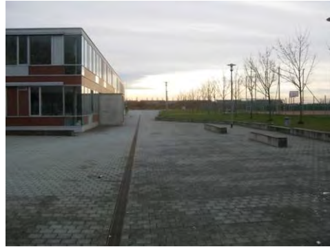
Anbau Sir-William-Herschel-Mittelschule mit Freiflächengestaltung (Stadt Ingolstadt)
