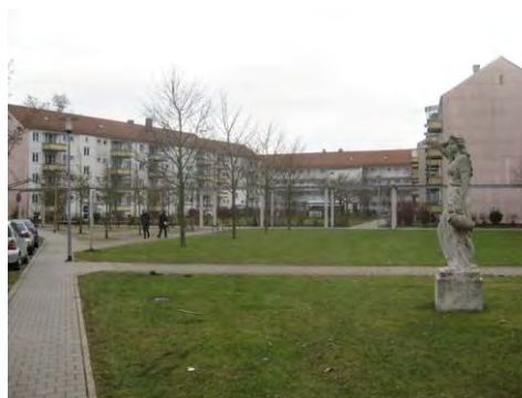
Sanierung Wohngebäude und Wohnumfeldgestaltung Leharhof, Leharstraße (Südhausbau KG)
