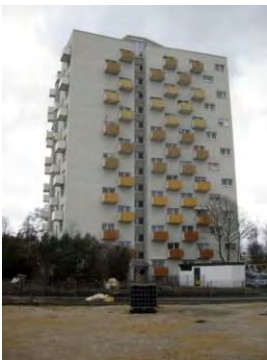
Sanierung Wohngebäude Goethestraße (WEG)
