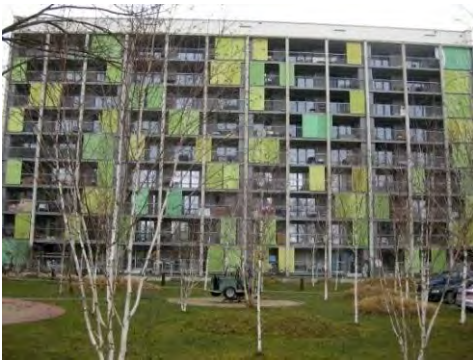
Sanierung Wohngebäude und Wohnumfeldgestaltung Dörflerstraße (GWG)
