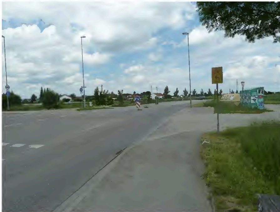
Blick von West nach Ost
